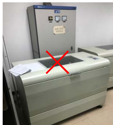
图 4. 勿遮挡配电箱开关
